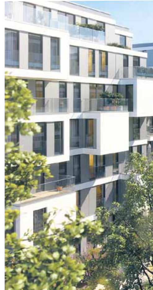
Haase Wohnbau realisiert das „Rathenau Karree“ mit KfW-70-Standard und Photovoltaikanlage
