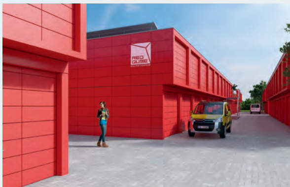
In Köln-Pesch entsteht ein Storage-Park mit 283 Einheiten.
